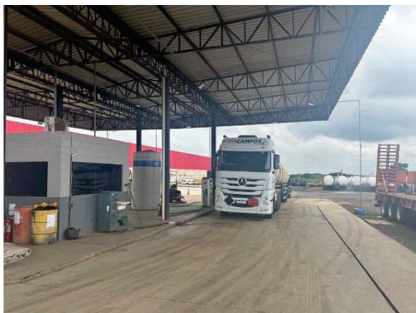
FIGURA 3— POSTO DE ABASTECIMENTO INTERNO
