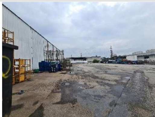
Lateral do galpão G
