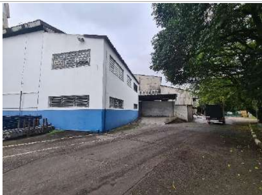
Lateral do galpão G
