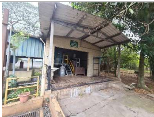
Estação de Tratamento de Efluentes
