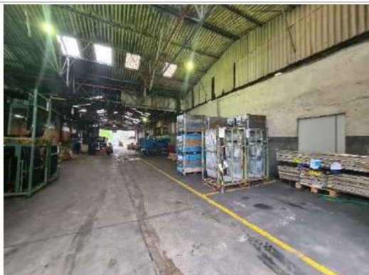
Interior do galpão F
