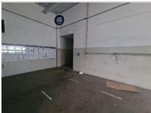
Interior do galpão da antiga Nakata
