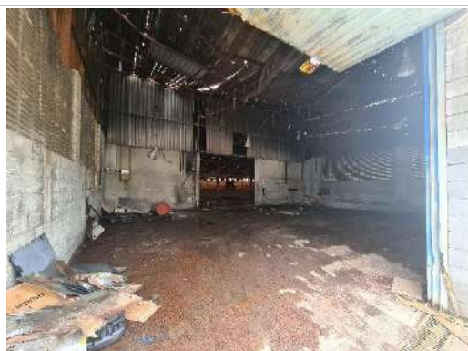
Interior de edificação anexa ao galpão A
