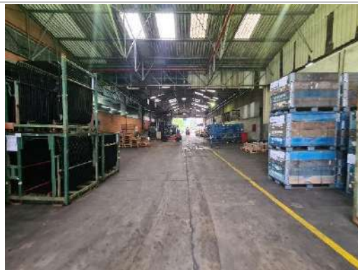
Interior do galpão F
