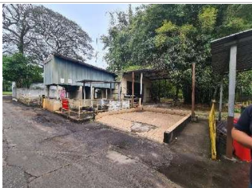
Estação de Tratamento de Efluentes
