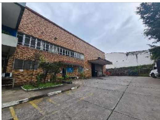
Fachada do galpão E
