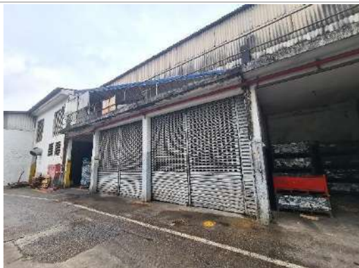
Exterior do galpão F
