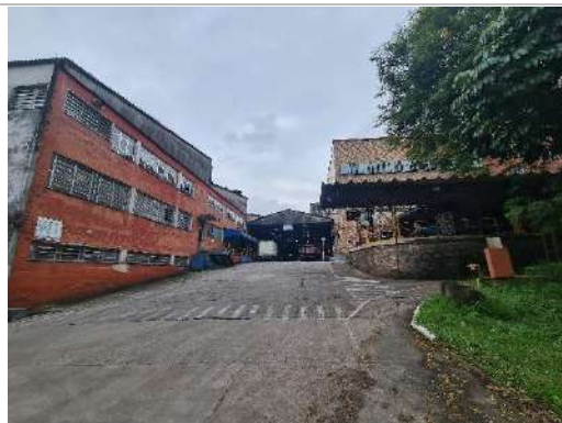
Circulação entre os galpões A (esquerda) e C (direita)
