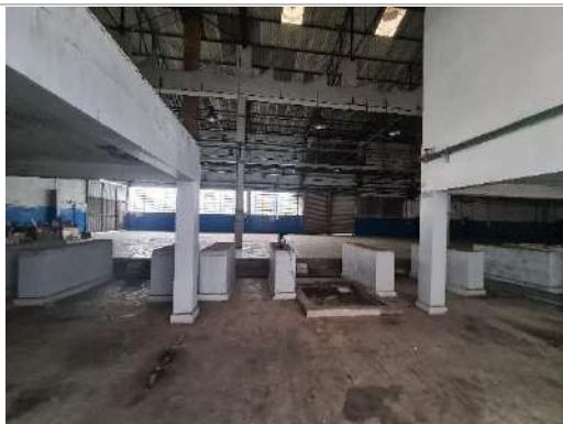
Interior do galpão A
