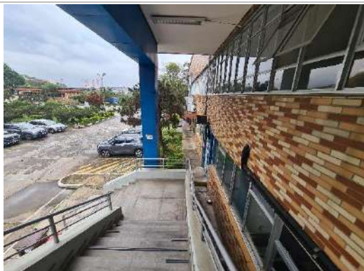
Escada no exterior do galpão E
