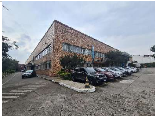
Exterior do galpão e
