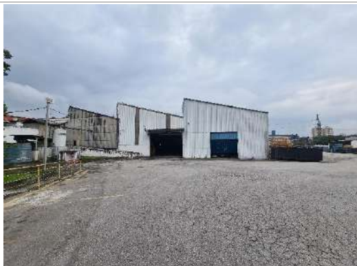
Fachada do galpão G
