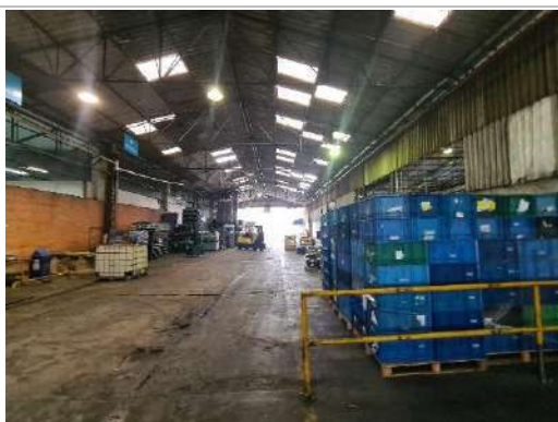
Interior do galpão F
