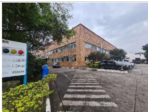
Fachada do galpão C
