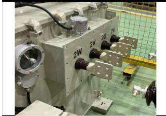
FOTO 2 (Photo 2): Inspeção visual
