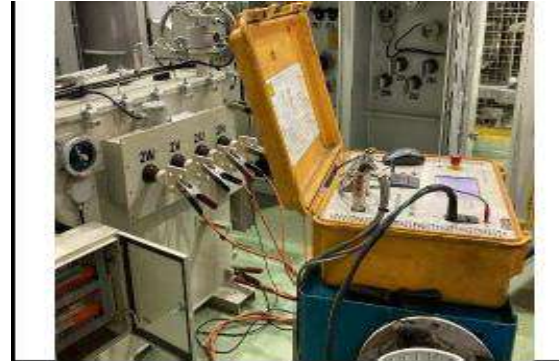
FOTO 4 (Photo 4): Preparação para ensaios
