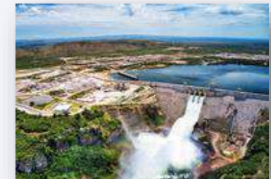
Usina Hidrelétrica de Laúca Angola
