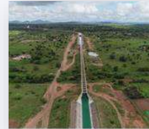
Canal Adutor do Sertão Alagoano (trecho 4).
