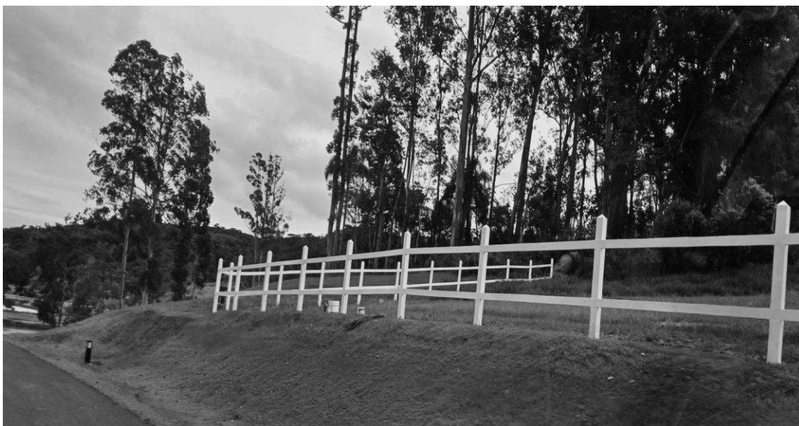
Detalhe de execução de pintura em cercas do Lote 04.
