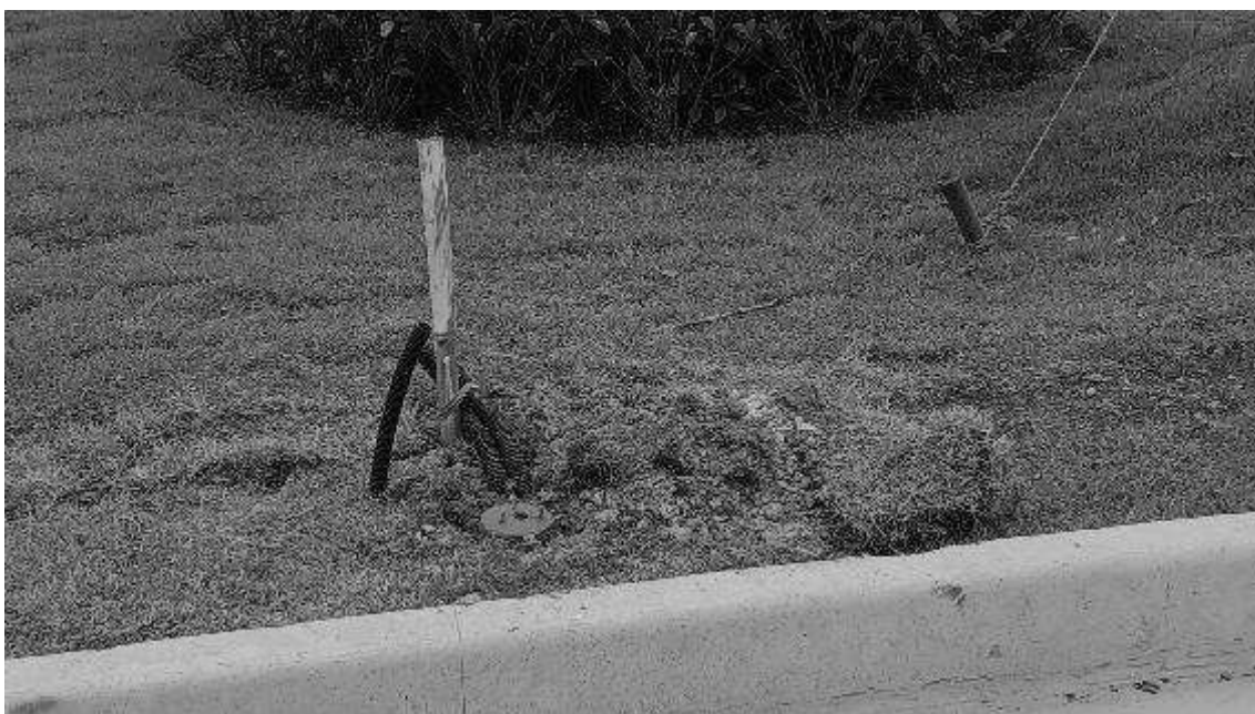
Detalhe de concretagem de bases redondas para os balizadores.
