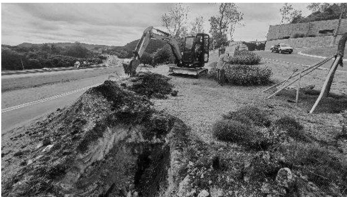
Detalhe de execução de covas para replantio para amanhã.
