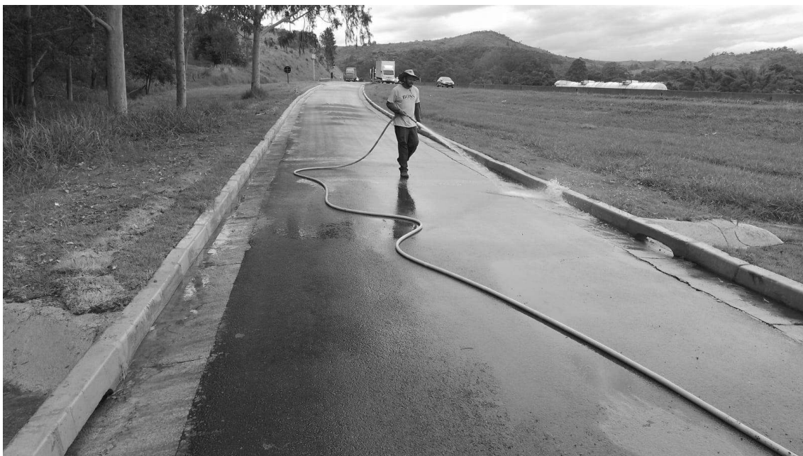
Detalhe de lavagem de pavimento, acesso Haras.
