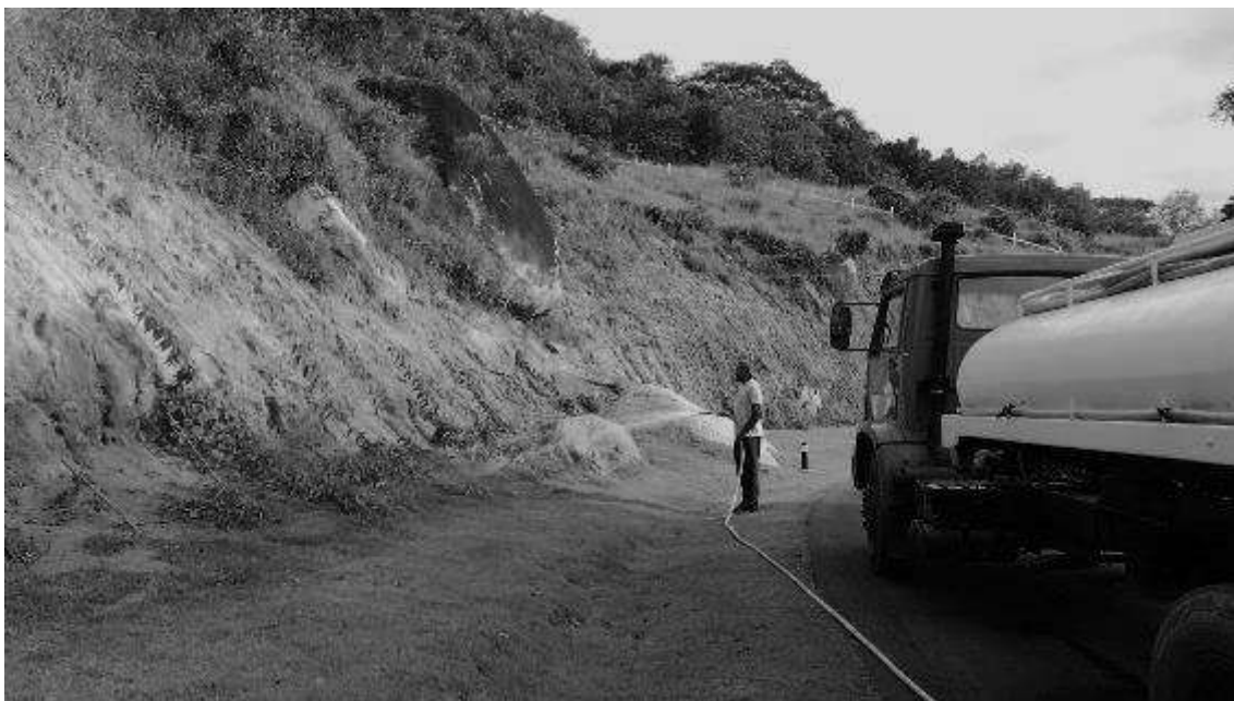
Detalhe de irrigação de tumbergias, talude do Lote 10.
