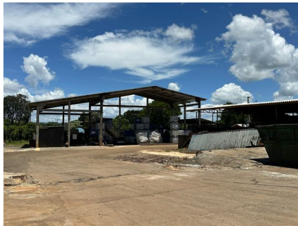
Sistema de tratamento de fluentes.
