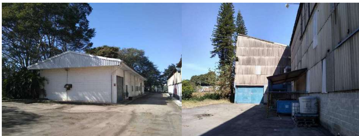
Fotos 10 apresenta vista externa do prédio de apoio e foto 11 vista externa do barracão.
