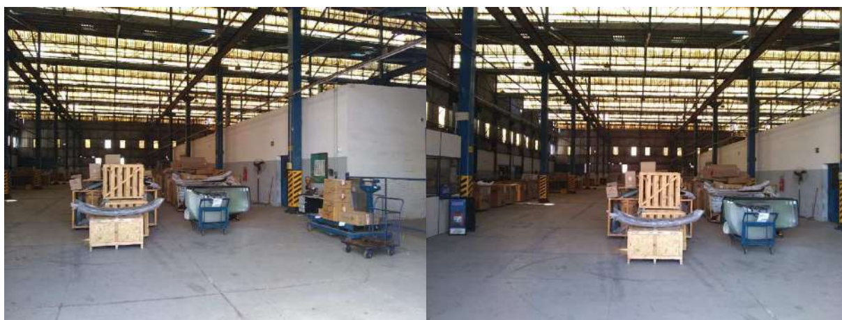
Fotos 36 e 37 apresentam vistas parciais internas do barracão.
