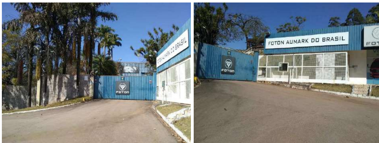
Fotos 02 e 03 – Vista do acesso principal do imóvel, visto externamente.
