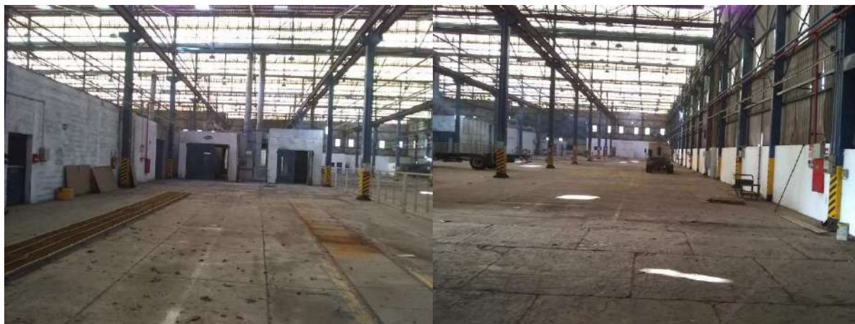
Fotos 32 e 33 apresentam vistas parciais internas do barracão.
