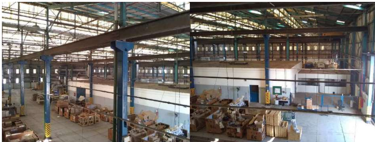
Fotos 24 e 25 apresentam vistas parciais internas do barracão.
