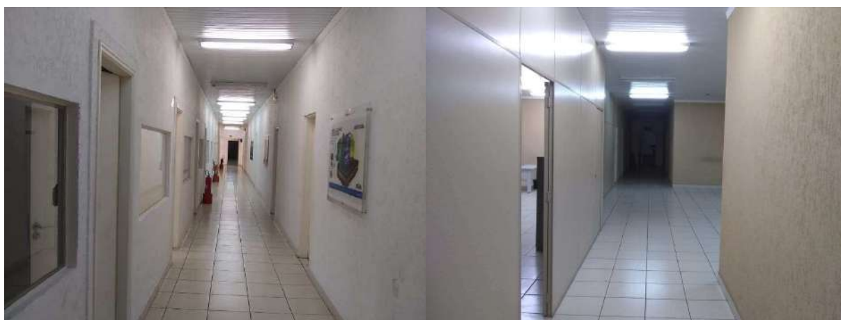
Fotos 16 e 17 apresentam vistas parciais internas do prédio administrativo.
