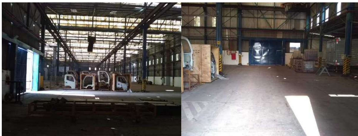
Fotos 34 e 35 apresentam vistas parciais internas do barracão.
