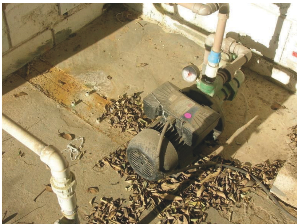
ITEM 1,273 - BOMBA CENTRÍFUGA THEBE DLYY8012 MOTOR 1,5 CV MONOFÁSICO
