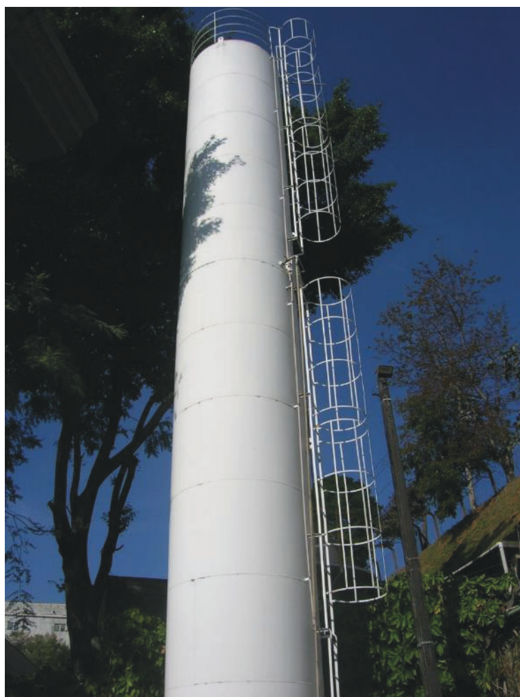
ITEM 1,246 - CASTELO D'ÁGUA METÁLICO 50.000 L
