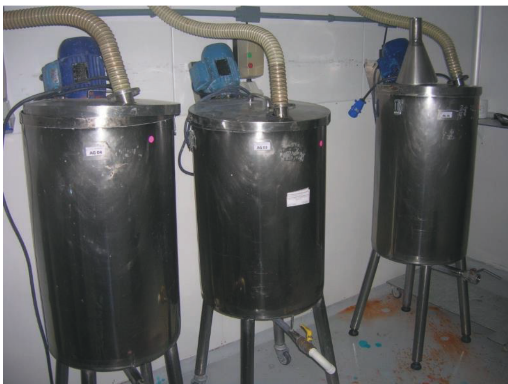
ITENS 1,423 / 1,424 / 1,428 - TANQUES EM INOX
