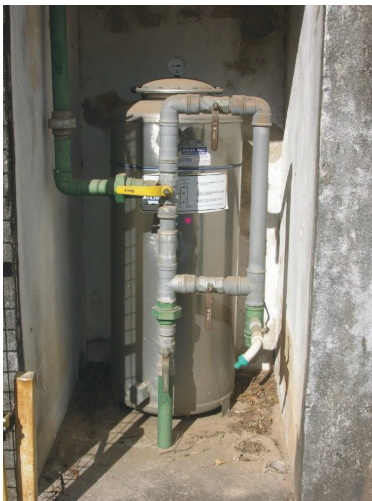
ITEM 1,245 - FILTRO DE ÁGUA FILTRALLI CORPO EM INOX
