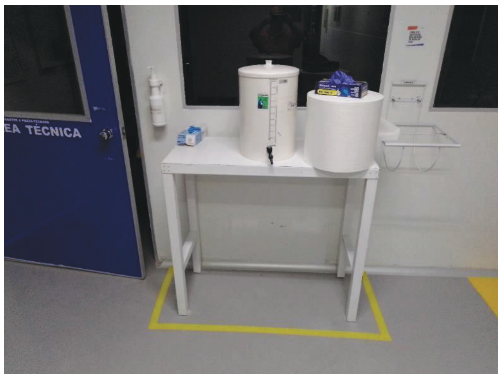
ITENS 1,390 / 1,391 - BANCADA EM AÇO ESMALTADO E BARRILETE EM PEAD 20 L
