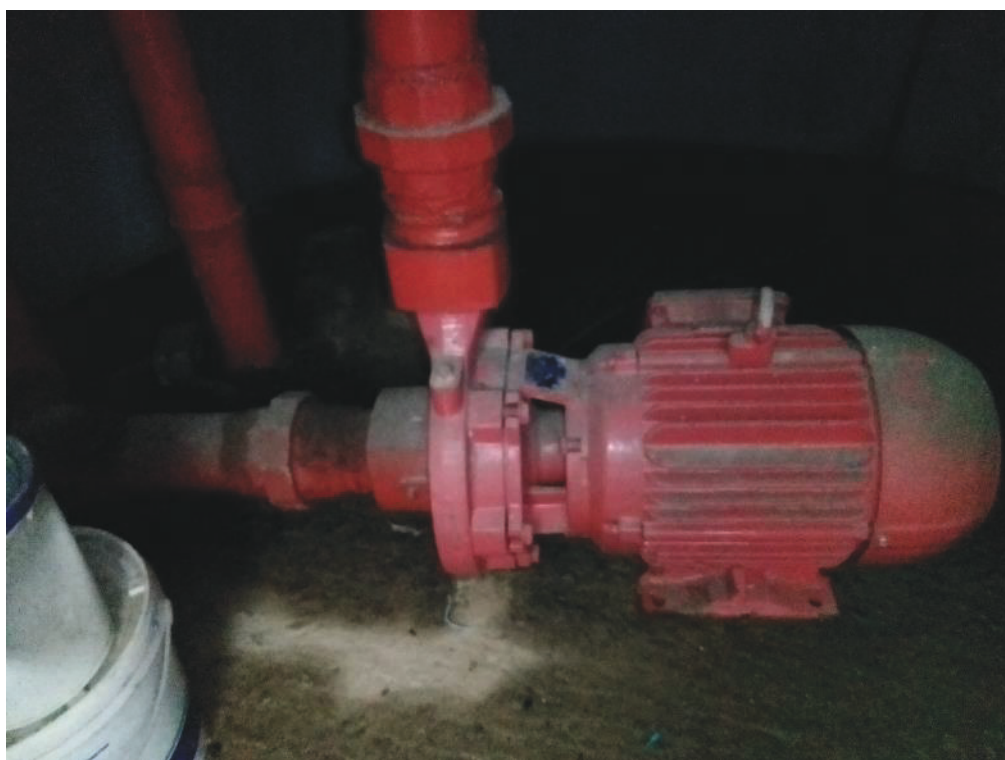
ITEM 1,900 - BOMBA PARA INCENDIO KSB FIREBLOC 32-160
