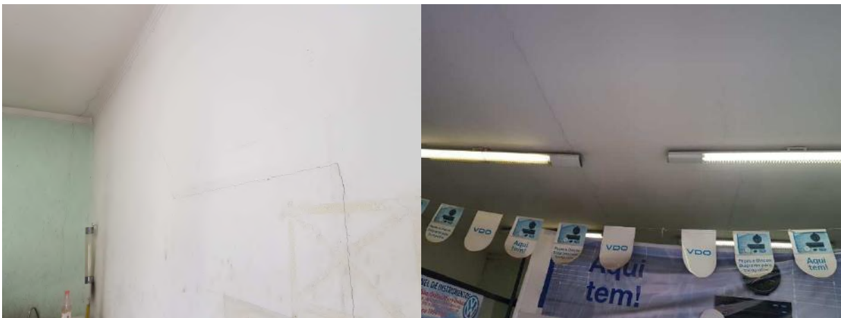
Fonte: Wert Engenharia
